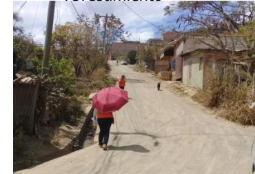
Calles Vehiculares sin revestimiento
